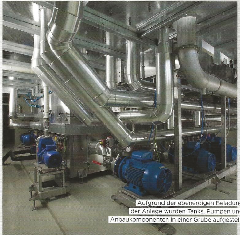
Aufgrund der ebenerdigen Beladung der Anlage wurden Tanks, Pumpen und Anbaukomponenten in einer Grube aufgestellt
